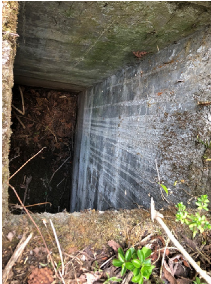
Secuencia de los tubos y caja de cemento abandonados del Sector II de Salquil Grande. Foto: El Observador, 26/04/2023.
