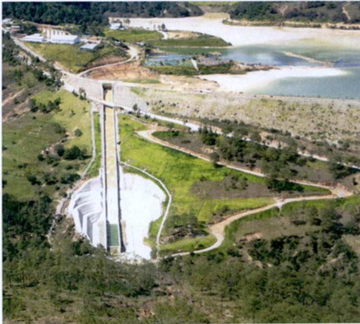
Fotografía 5.3. Aliviadero o Spillway para descarga de agua de la Represa
