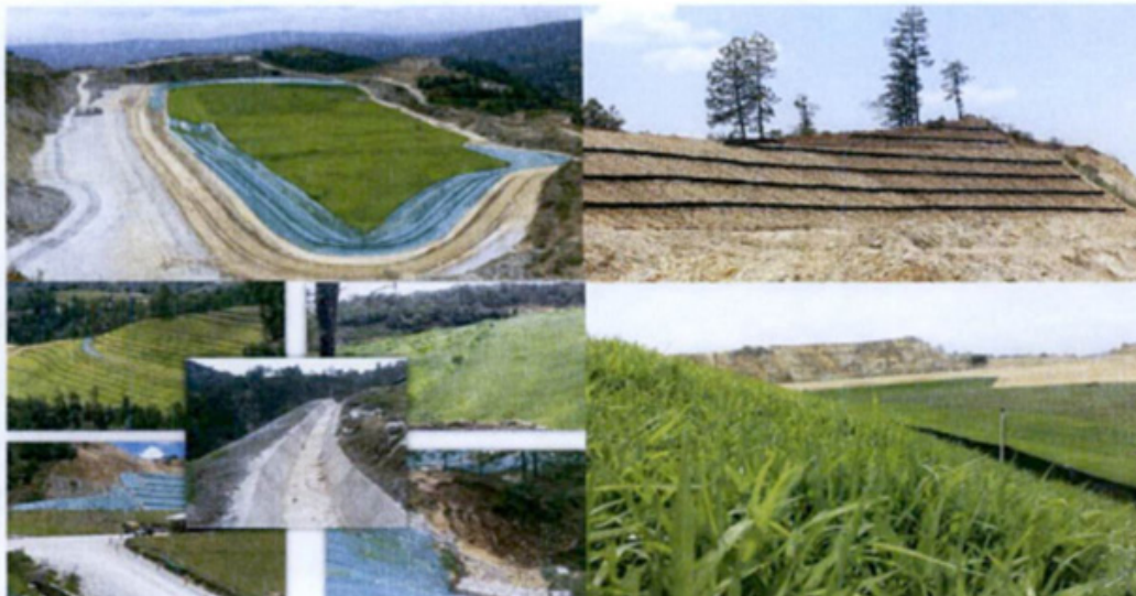
En las fotografías se pueden visualizar las estructuras mineras por donde corre la escorrentía.
