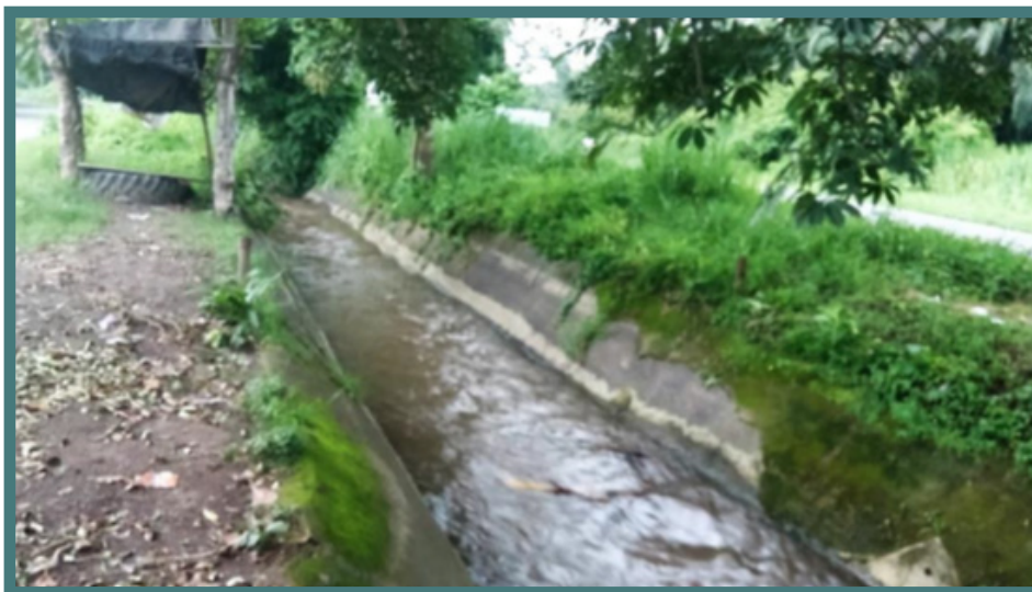
Desvío del Río Madre Vieja construido por el Grupo HAME, Nueva Concepción, Escuintla. Foto: Carmen Reina.
