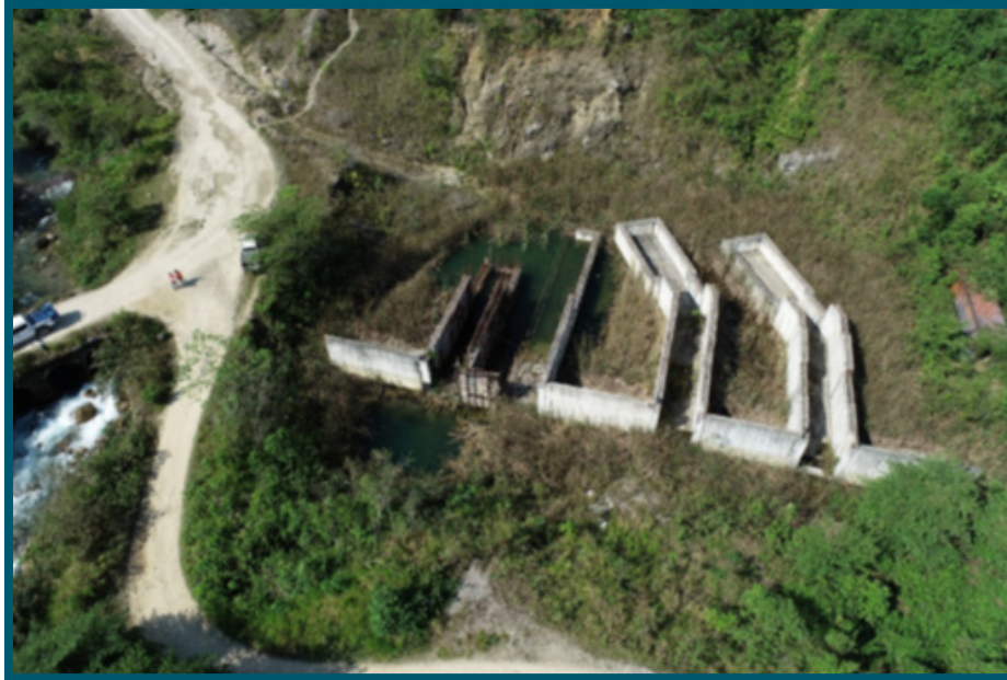
Casa de máquinas Generadora San Mateo (GSM)/Generadora San Andrés (GSA).
