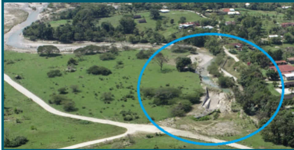
Captación Río Pojom (Desarenador)
