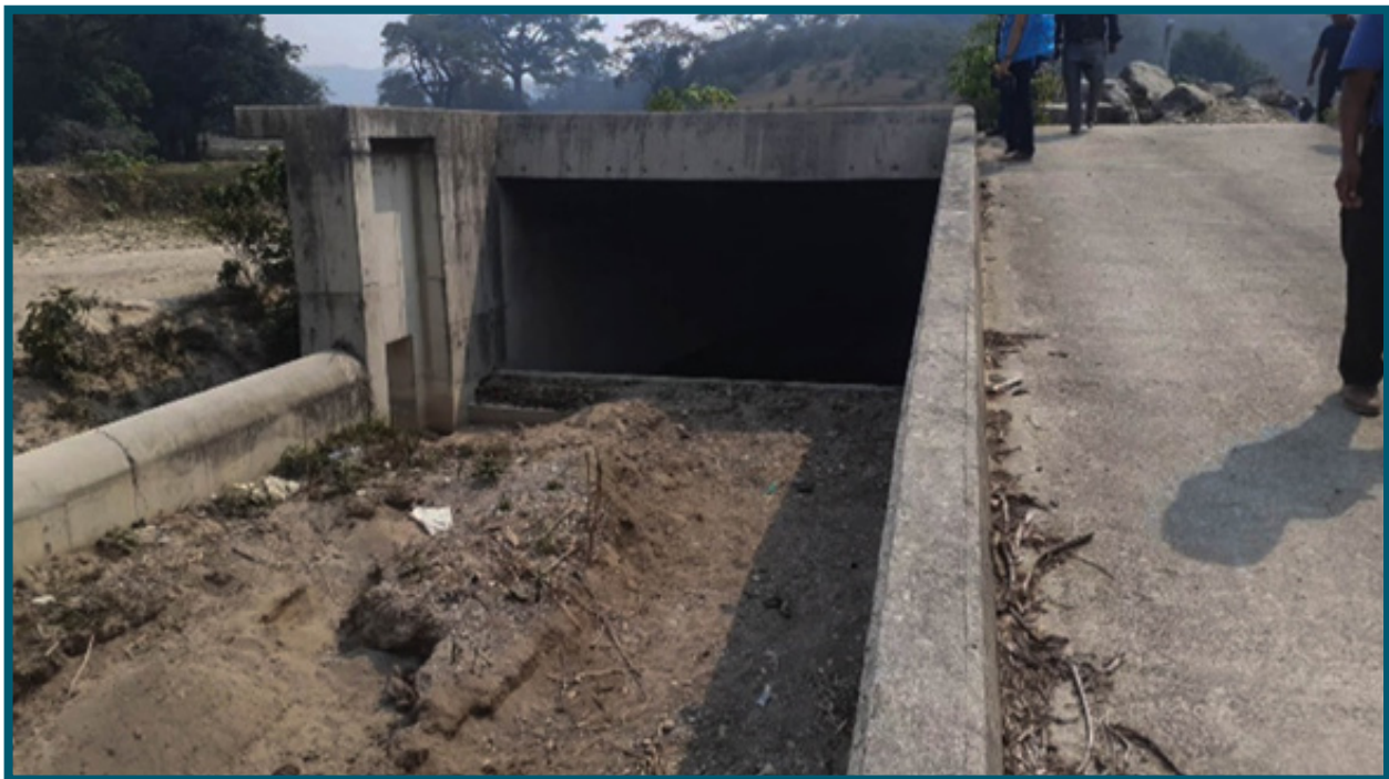
Desvío del Río Pojom que quedó abandonado. Foto: Prensa Comunitaria, junio 2024.
