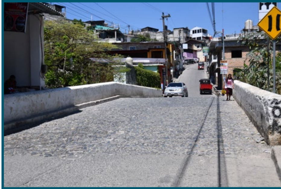
Antiguo puente localizado en el Barrio La Cruz en el casco urbano de San Ildefonso Ixtahuacán. Obra realizada con mano de obra no calificada de la población, con material de cal y piedra. Anteriormente al gobierno municipal del Comité Cívico “El Gallo”, probablemente la población Mam fue obligada por las autoridades municipales de entonces.
