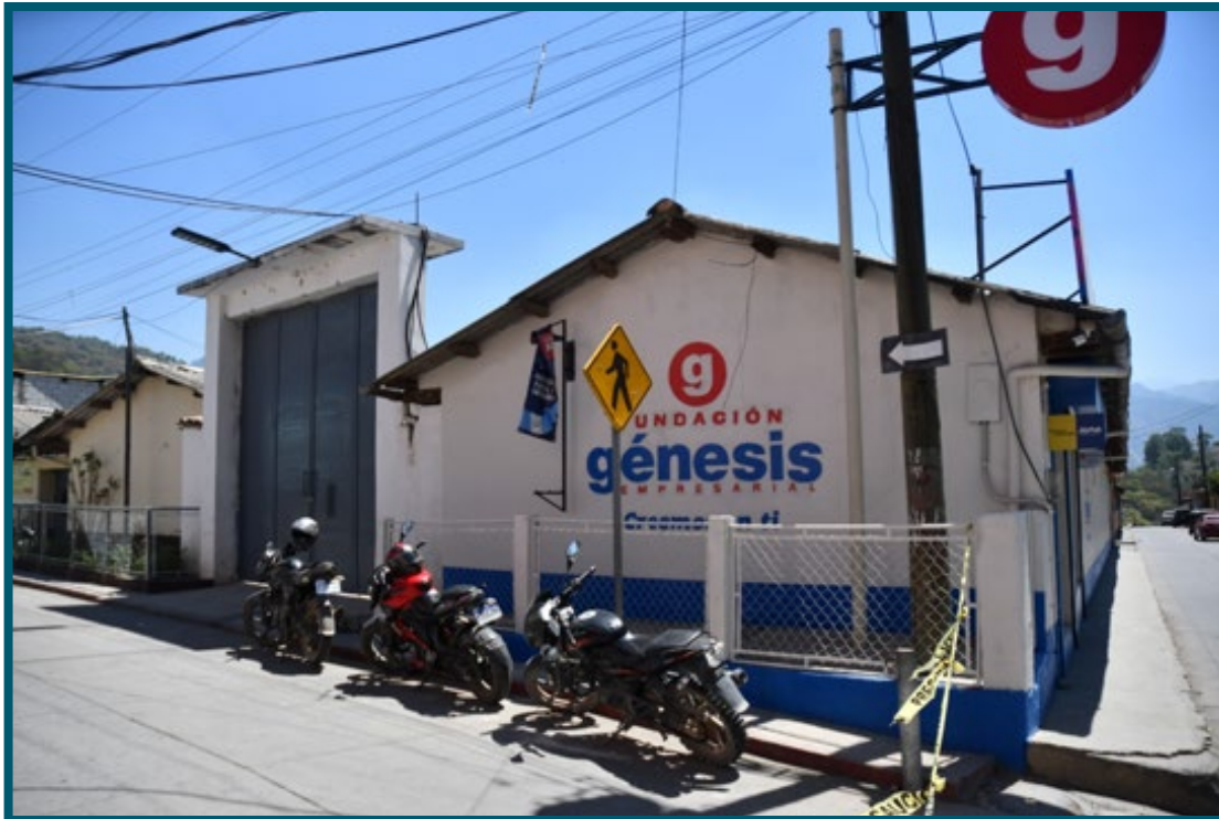
Edificio del internado de la parroquia de San Ildefonso Ixtahuacán localizado en el casco urbano, y en donde estuvieron internados los niños que posteriormente apoyaron la conformación del Comité Cívico “El Gallo”.
