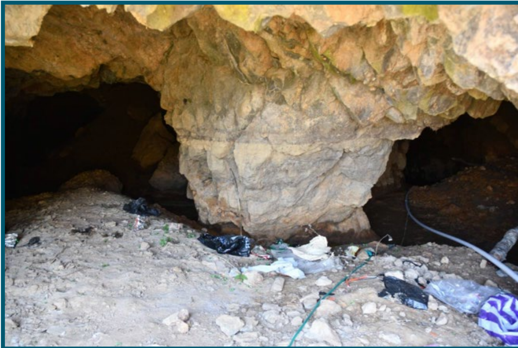
Entrada a la mina.
