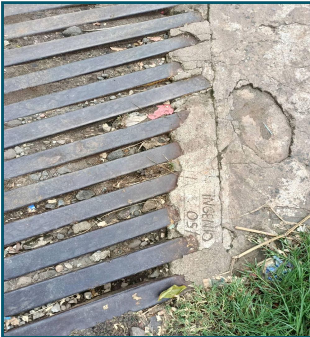
Rejilla vinculada con infraestructura del Ingenio El Pilar, ubicada inmediatamente antes del puente de Pajales Sector Sis.
