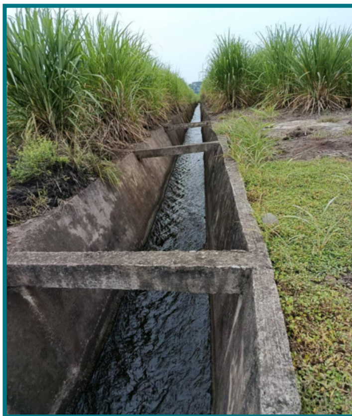
Canal abierto utilizado para la conducción de aguas residuales industriales del Ingenio El Pilar hacia el Ingenio Tululá, en el entorno de Pajales Sector Sis.
